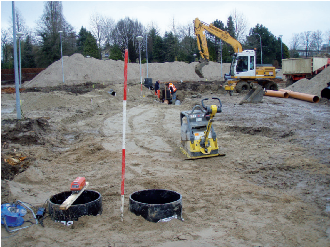
Afbeelding 4. Overzicht van de werkzaamheden bij aanleg van de riolering.
