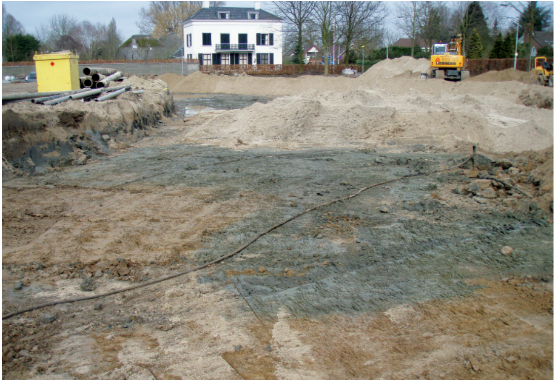
Afbeelding 6. Overzicht van het aanleggen van de bouwput in de zuidoost hoek van het plangebied.
