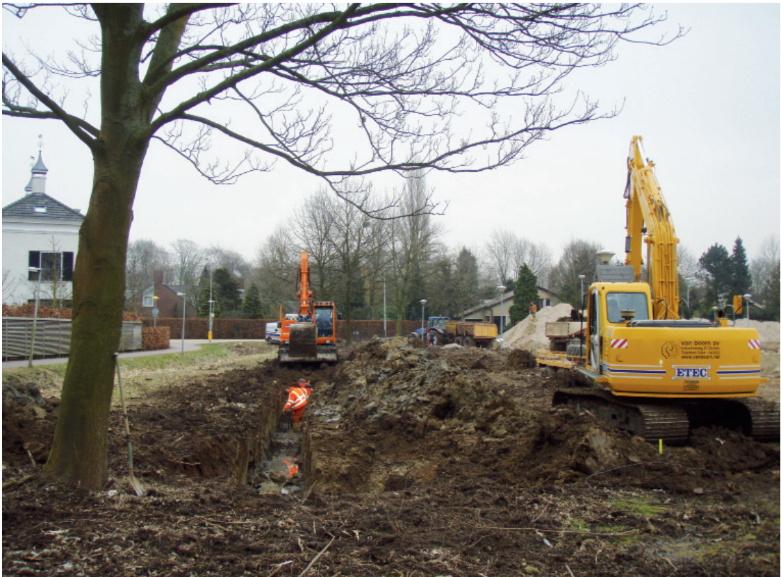
Afbeelding 5. Overzicht van de werkzaamheden bij het omleggen van de waterleiding.
